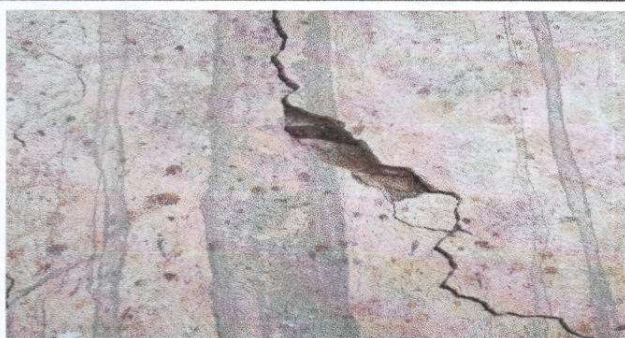
Foto 7: Repello y cernido en muro
