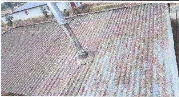
Foto 1: Sustrucción de lámina, por lámina troquelda aluzinc calibre 26
